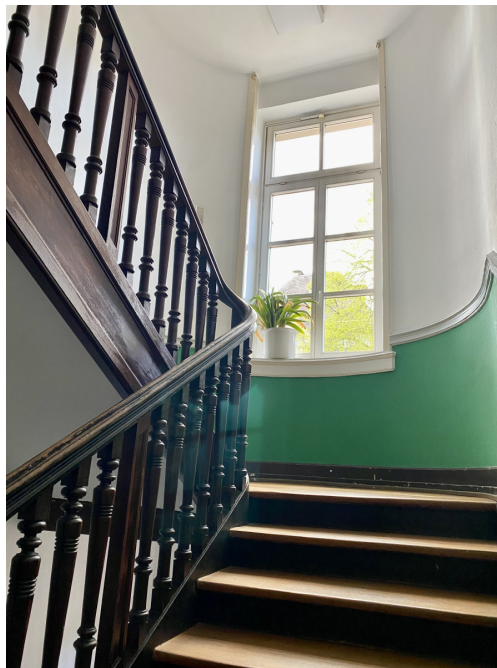
Treppenhaus im Haus der Beratung
